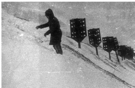
Рис. 7. Кольктафели вдоль полотна автодороги предотвращают образование снежного карниза и оставляют верховье опасного склона без снега
