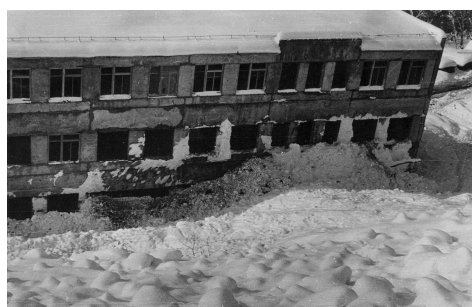
Рис. 4. Снежный карниз, сорвавшийся на заснеженный склон, вызвал снежную лавину, которая поразила даже второй этаж капитального строения у подножья лавиноопасного склона.
