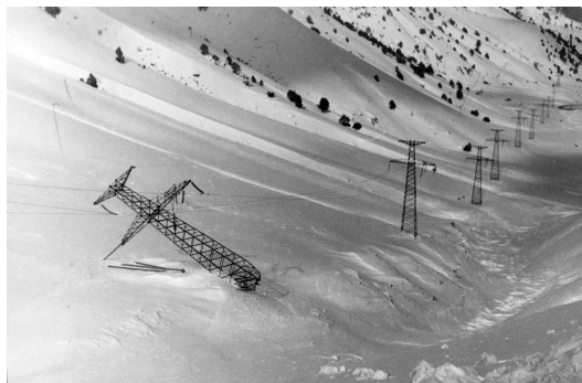
Рис. 1. Опора линии электропередачи, поваленная лавиной. Неправильно выбрано место установки опоры.
