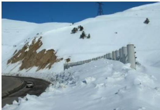
Рис. 11. Защитная дамба вдоль дороги для удержания снега
