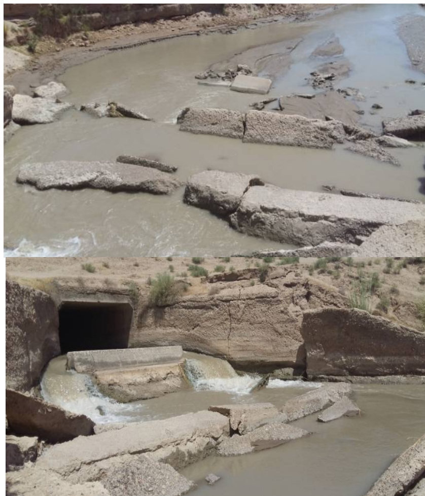
Рис. 1. Современное состояние нижнего бьефа водопропускного сооружения
