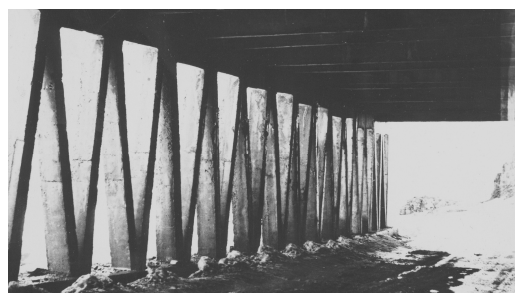
Рис. 10. Галерея на автомобильной трассе для пропуска лавин по крыше
