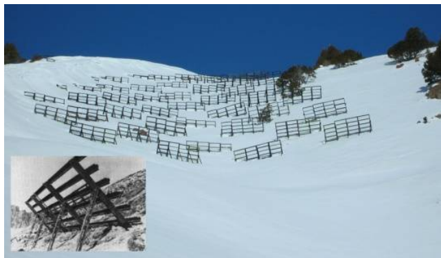
Рис. 5. Снегоудерживающие щиты на горном склоне в зоне возможного зарождения снежной лавины. Внизу слева – металлическая конструкция щита.
