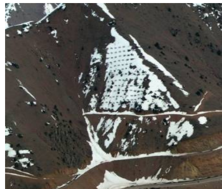
Рис. 6. Левый склон очищен от снега лавиной, внизу – снежный конус выноса. Сход лавины с правого склона предотвращен щитами и террасой.
